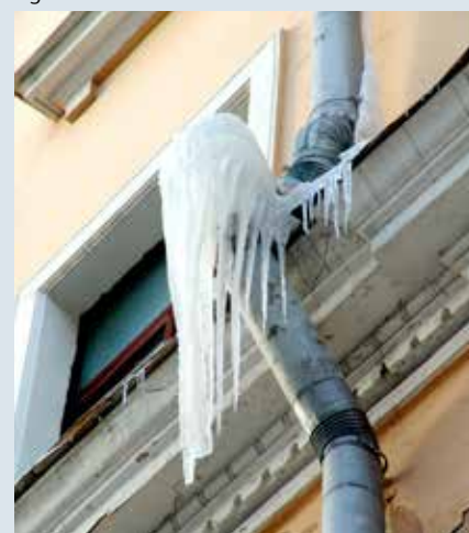
Fig. 2-14 Tuberías heladas
