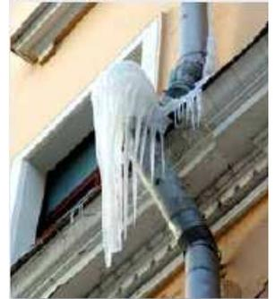
Fig. 2-14 Tuberías heladas
