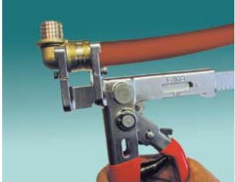
Зажимное устройство приводится в действие последовательными нажатиями до тех пор пока втулка не дойдет до края.
