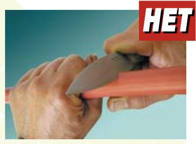
6. Работать в удобном положении. Работайте всегда на верстаке, поддерживая пресс на тренажере. Избегайте работать на стене или на земле. **Секрет сокращения времени монтажа – это предварительный монтаж трубопровода в удобном положении, затем расправить трубопровод на стене, используя гибкость труб и возможность вращения соединений BARBI.**
